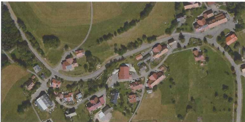
Abbildung 8: Luftbild, zur Veranschaulichung der Dachformen. Ausschnitt Ortsteil Wolpadingen, unmaßstäblich (LUBW)
